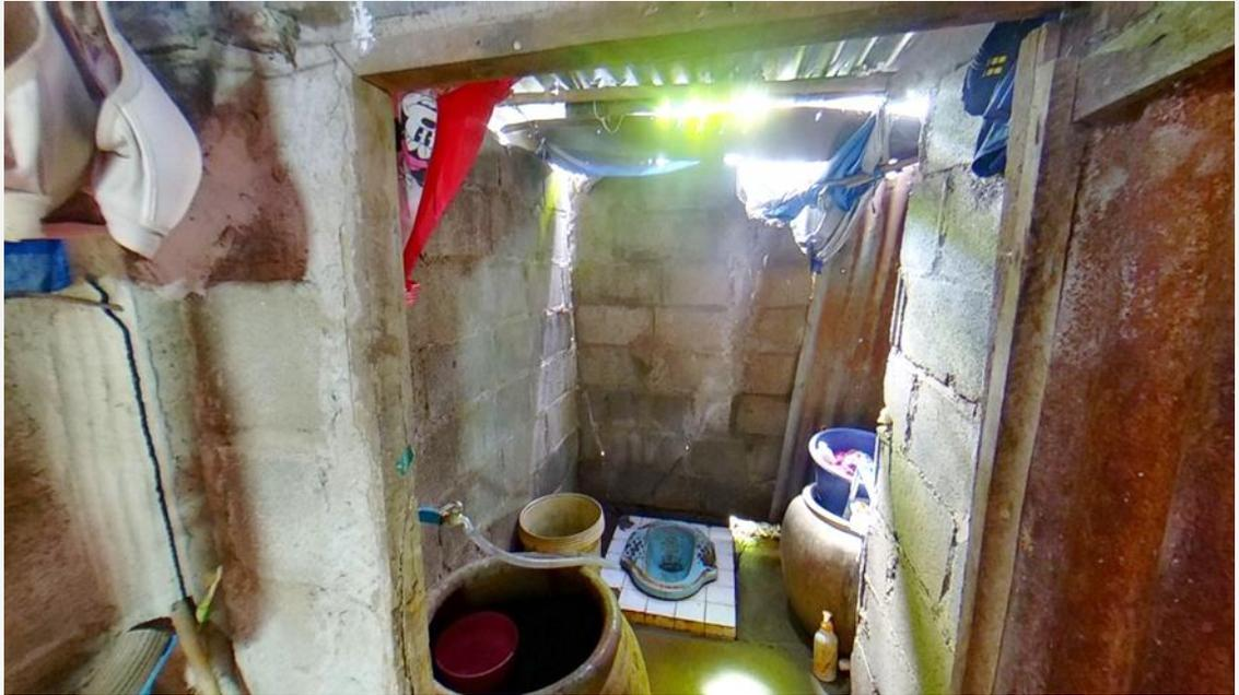
【ウドンターニー。世帯月収14,999THB以下の所得水準が低い層の戸建て。しゃがむタイプのトイレ。流す時は手桶などで水を上からかける必要がある】出典：
